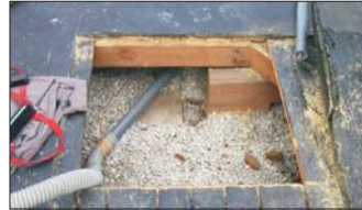
Wenige Einblasöffnungen genügen
